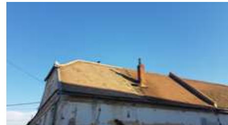
Reparare acoperiș și exterior—Centrul de Zi Arapamesu
